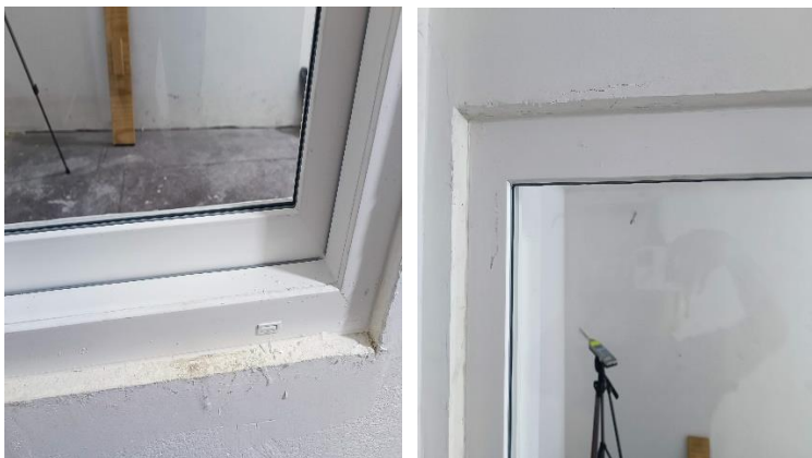
Imagen 4. Sellamiento contra el vano.
